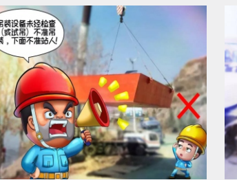
设备吊装作业时，应先对设备进行检查，确认设备性能完好。起吊前，应先进行试吊，吊装过程中，下方不准站人
